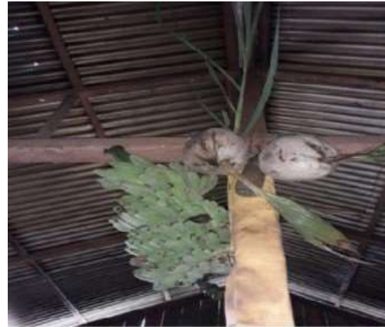
Gambar 2. Tiang tengah (dokumentasi peneliti)
